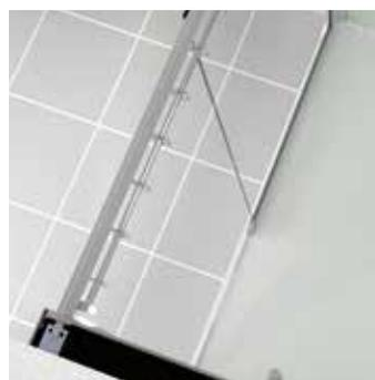
**Rampe d'accès (voir dimensions p.101), la hauteur du receveur doit être de 5 cm**
